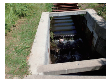
図13 隣接水路(駒寄川)大岡橋手前
